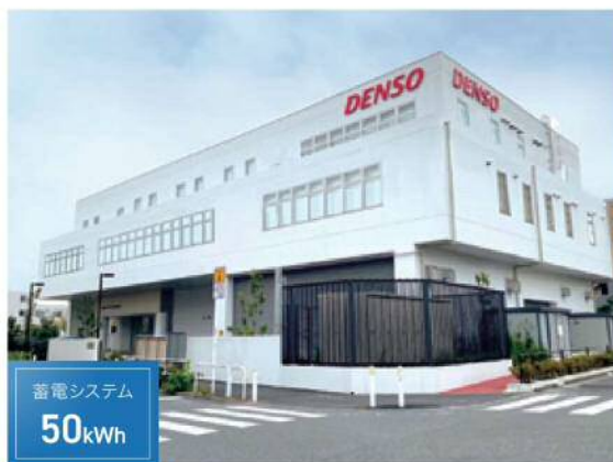
東京都板橋区 2019年 株式会社デンソーソリューション関東支社 様 単相ラインバックマイスター 20kVA×1台
